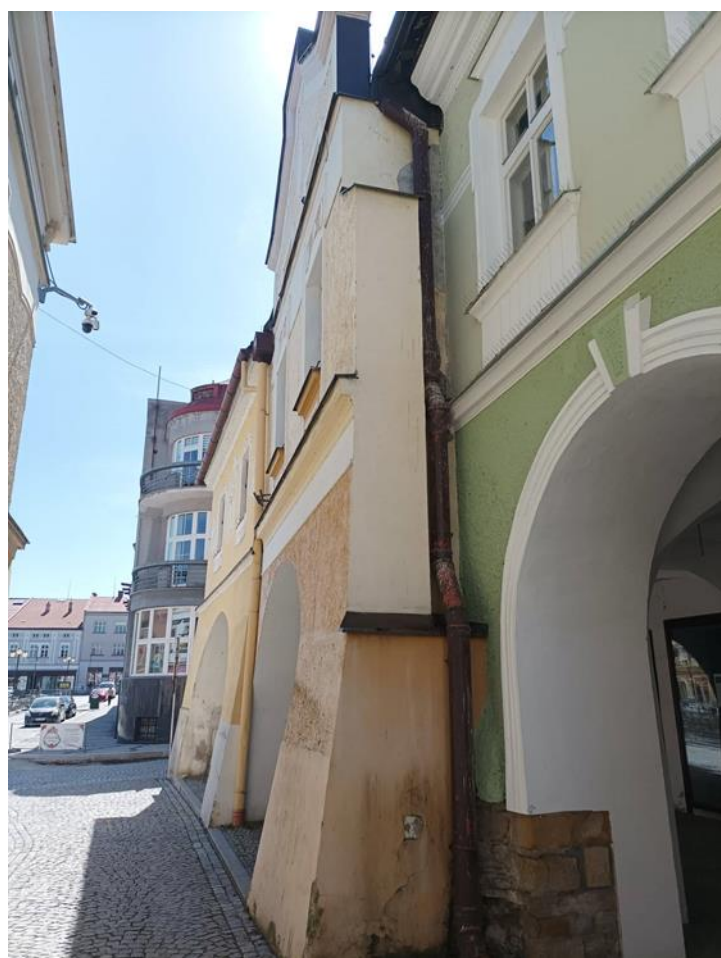
Obrázek 16 Měšťanský dům v Křížkovského ulici ve Valašském Meziříčí, jehož předsazené průčelí by mohlo být dokladem toho, že někteří méně zámožní měšťané byli původně schopni vybudovat pouze zděnou fasádu a zbytek objektu zatím zůstal dřevěný. (foto: autor 2022)
