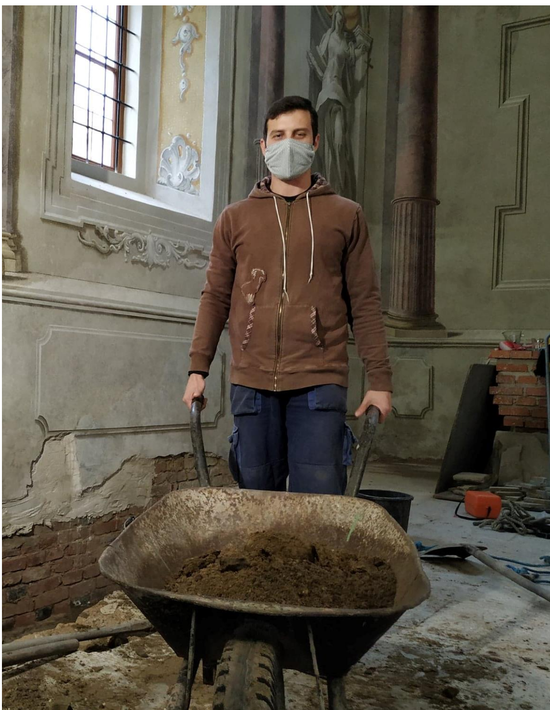
Obrázek 11 Práce na odvodňování kaple, Mgr. Jan Anlauf, archeolog a vedoucí Muzejního a galerijního centra v zámku Žerotínů ve Valašském Meziříčí (Foto: Archiv KZ Valašské Meziříčí)
